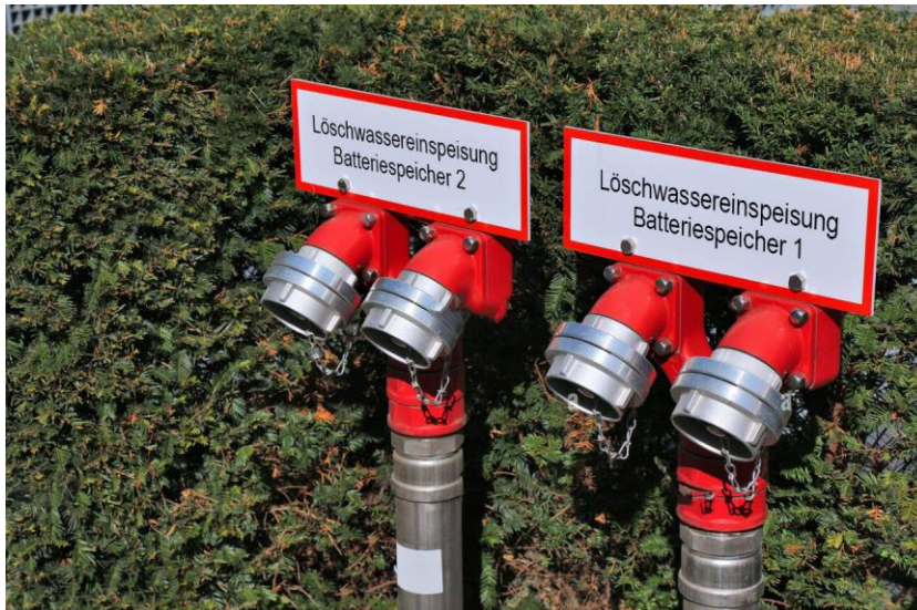
Geplante Löschwasser-Einspeisearmaturen nach DIN 14461 für die Batteriecontainer
