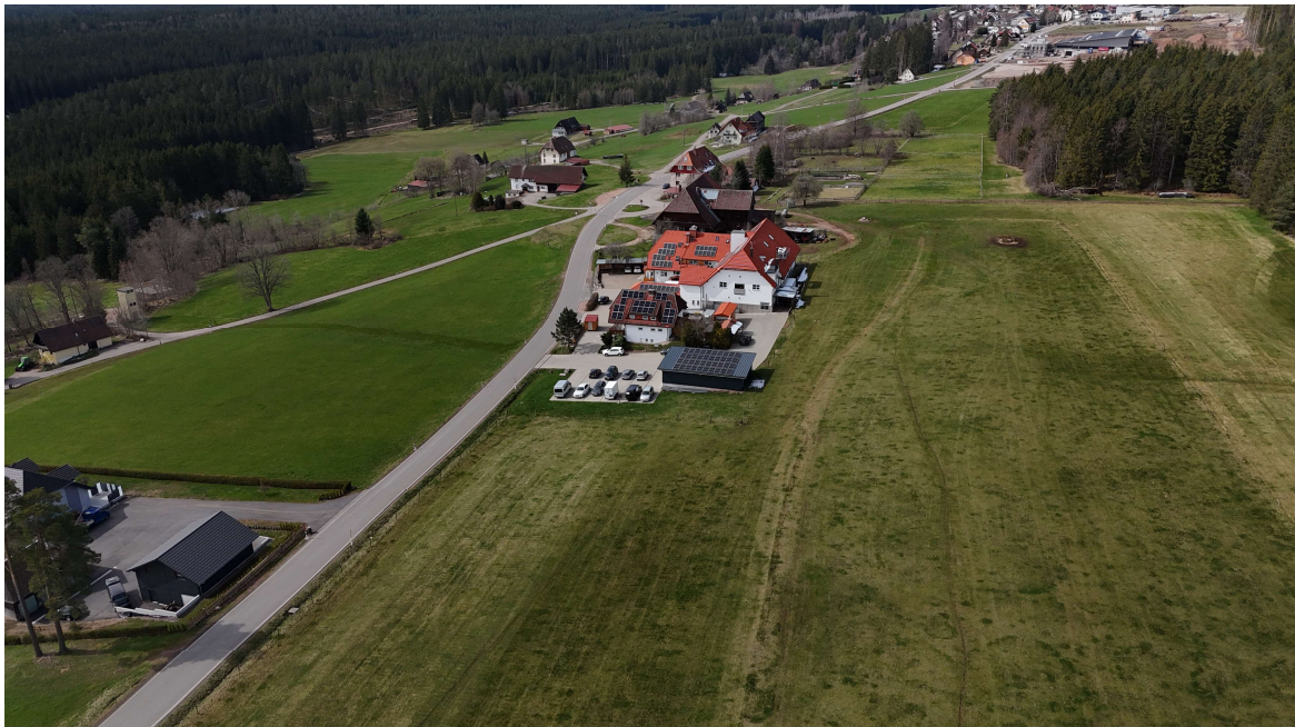
Abb. 15: Blick auf die FF-PVA in westliche Richtung
