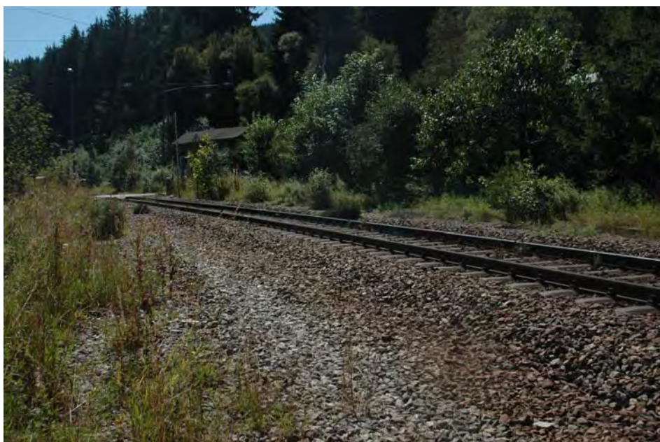
Abbildung 12: Bahndamm und angrenzende Schotterfläche auf Höhe der Rampe (Blick Richtung Süden).
