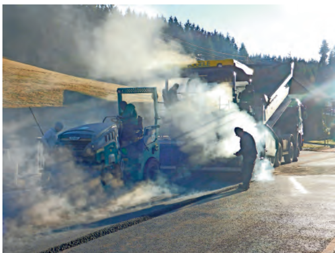
Einbau von bituminösem Asphalt am 6. Dezember 2016
