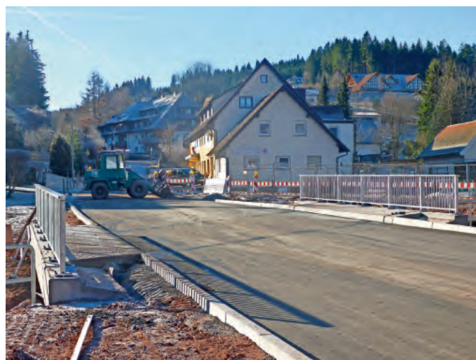
Die Fahrbahn kurz nach der Fertigstellung
